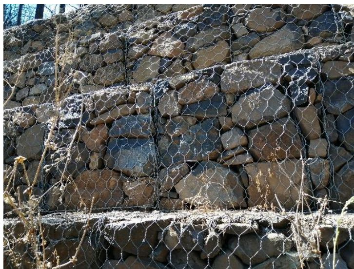
Foto detalle gavionada (fuente Documento Ambiental)
