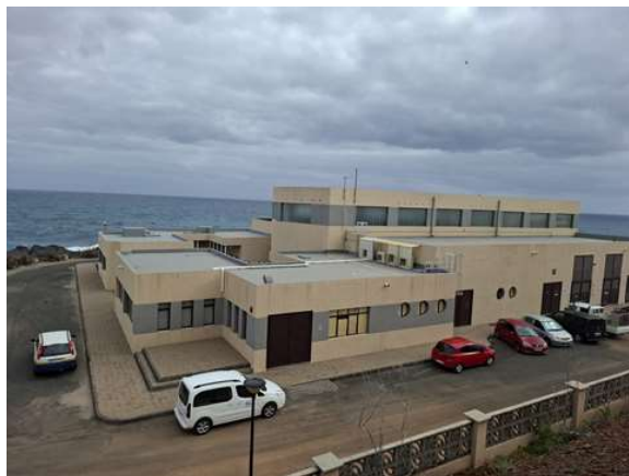
Vista general desde el sur. A la derecha fachada oeste. (Fuente: propia OAOA)
