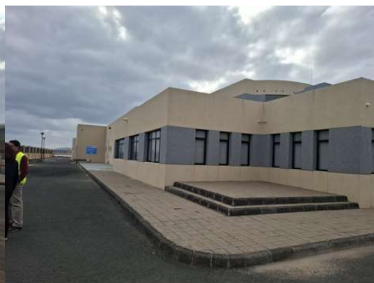
Fachada norte. (Fuente: propia OAOA)
